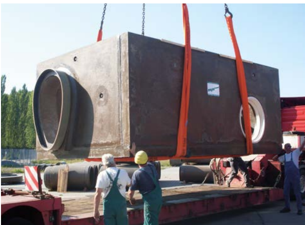
Przykłady komór studziennych wykonanych na indywidualne zamówienie
